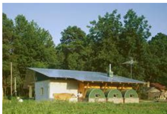
Figur 11: Bryant Haybale House, det første huset designet og bygget av Rural Studios i 1995 6
