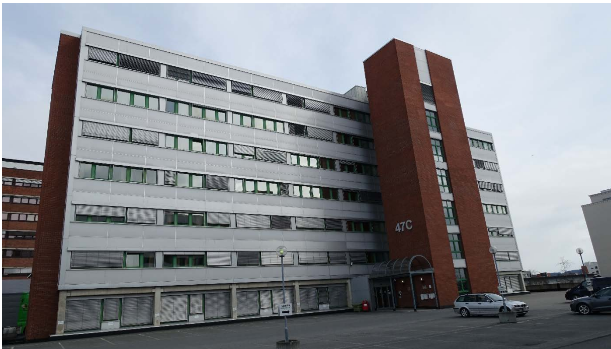
Figur 61: Bilde av bygget i Sinsenveien 47C 46
