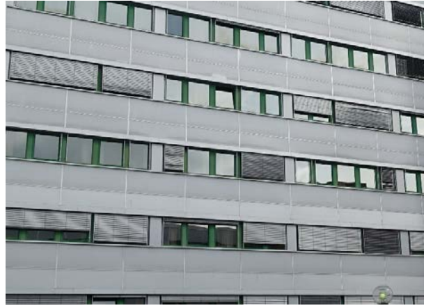
Figur 90: Metallfasadekledning fra Sinsenveien
