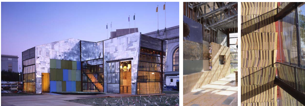
Figur 7: Scrap House; utvendig fasade og innvendig vegg kledd med telefonkataloger 4
