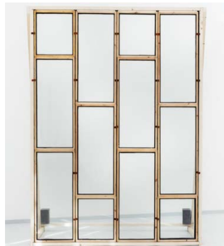
Figur 365: Innvendig glassvegg laget av ombrukte vegger 28
