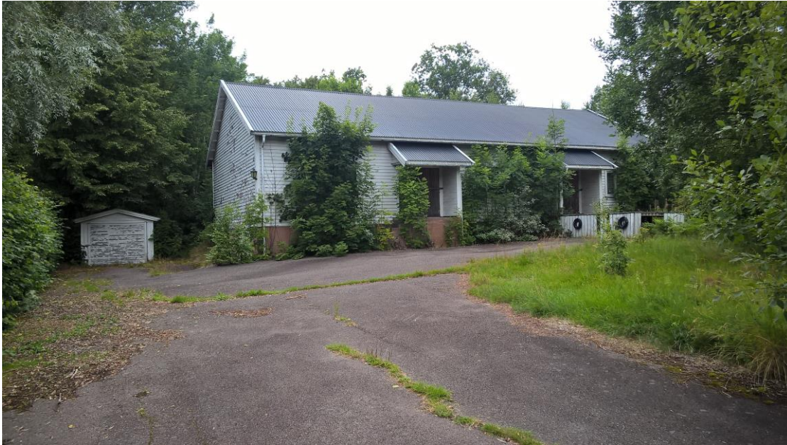
Figur 75: Lav tomteverdi. Melsomvikveien 587 i område 1, jf. figur 77, ble kjøpt opp allerede i 2012, trolig i påvente av kommunens ønske om høyere tetthet (Bilde: privat).
