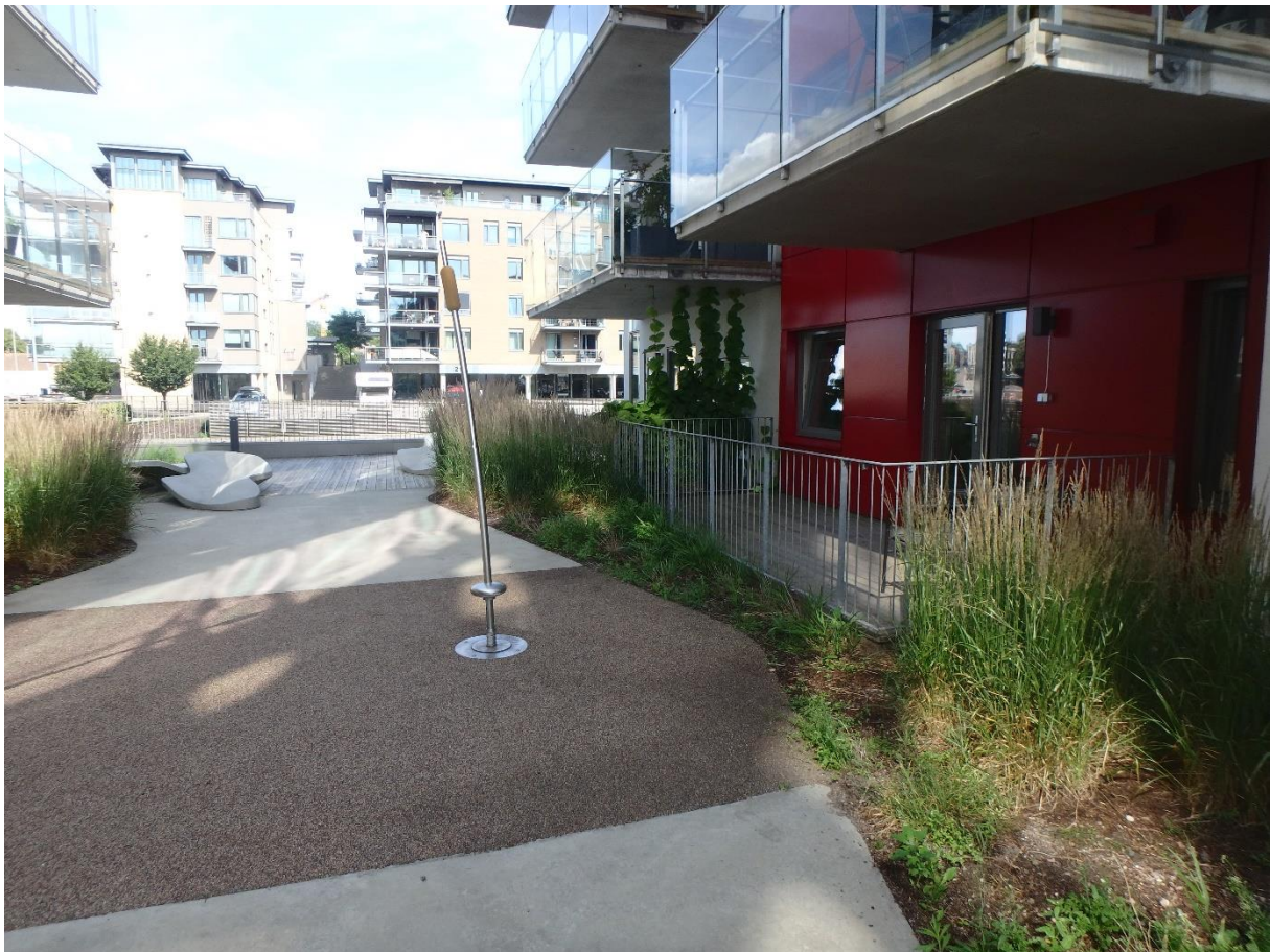
Figur 28: Skillet mellom felles uteoppholdsarealer og private terrasser er dårlig adskilt. Lekeapparatet («spinneren») i midten står snau to meter fra den private terrassen (Bilde: privat).
