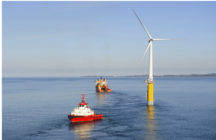
Figur 15-3 Hywind Demo 2009 - Forankring ved hjelp av AHTS og TUG (Fornybar.no 2016).
