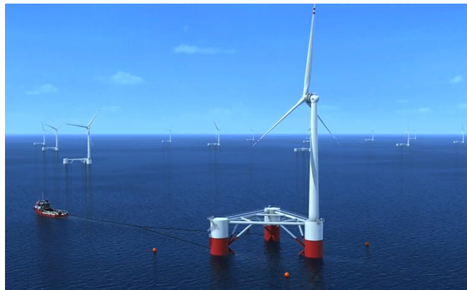
Figur 1-4 WindFloat – Halvt nedsenkbar plattform (Principal Power 2015).
