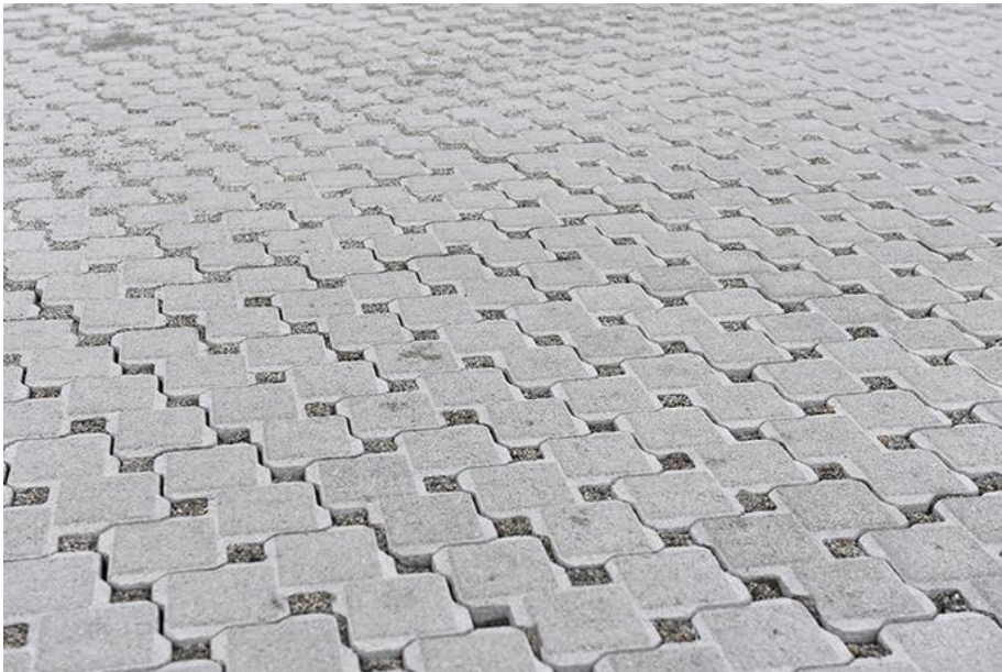
Figur 1.14 Permeabelt dekke med belegningsstein som slitelag (VA-forum 2015).
