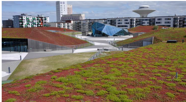
Figur 1.11 Et anlagt grønt tak på kjøpesenteret Emporia i Malmö. (Plaanja 2015)
