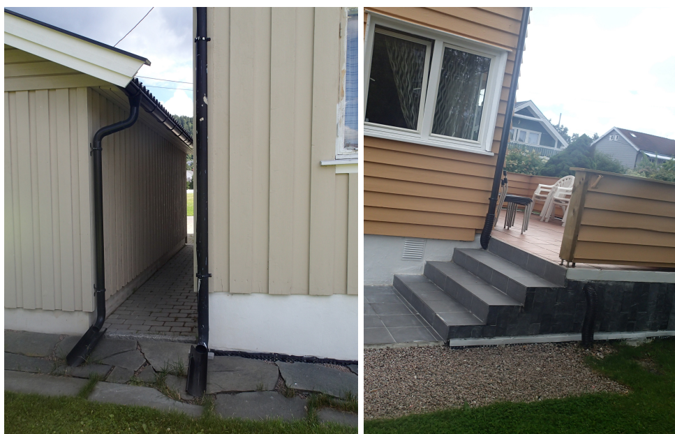
Figur 1.7 Eksempler på kreative frakoblede taknedløp på området Grefsen/Kjelsås tatt sommeren 2016. (Foto: Marthe C. Ingebrigtsen)
