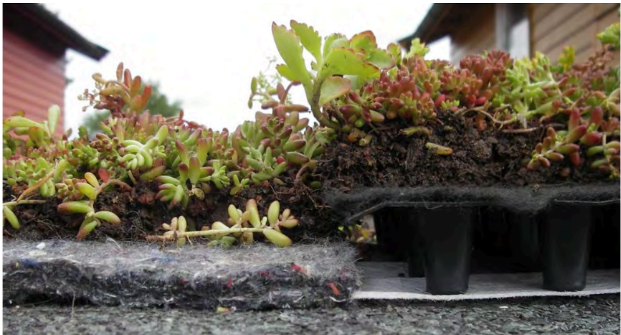
Figur 1.13 Eksempel på oppbygning av ekstensive grønne tak. (Foto: Bent C. Braskerud)
