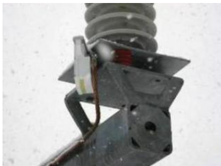
Figur 3.14: Her ser vi den monterte sensoren. Bildet er hentet fra [2]
