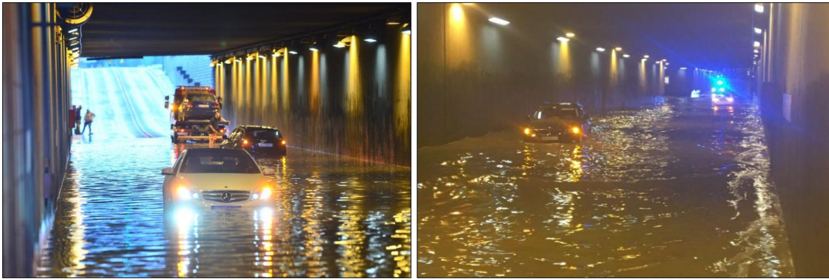
Figur 3-2: Oversvømmelser i Bragernestunnelen. Publisert i Drammens Tidende den 11. juli 2016. Foto: Rune Folkedal og Borgvald Moen.
