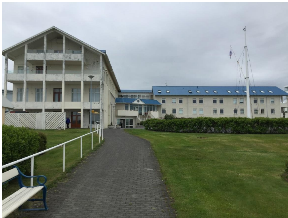
Figur 42. Hovedbygget som huser cafeen og de eldste beboerrommene
