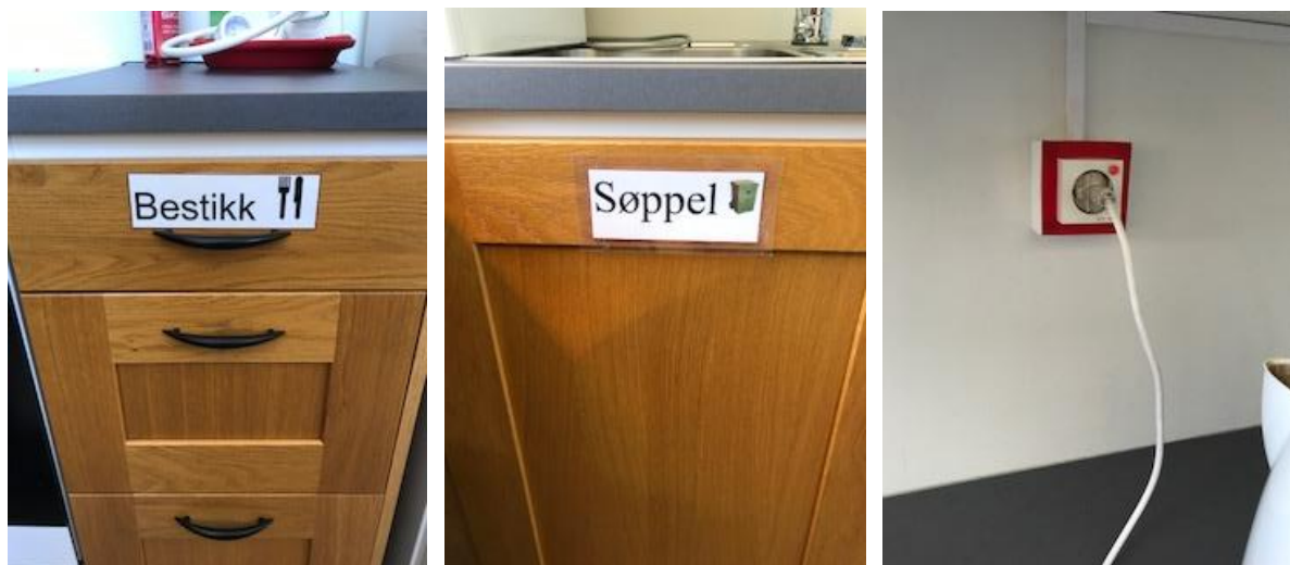
Figur 10 a (venstre) og b (midten) merking av kjøkkeninnredning, c (høyre) kontrastfarger på stikkontakter og lysbrytere
