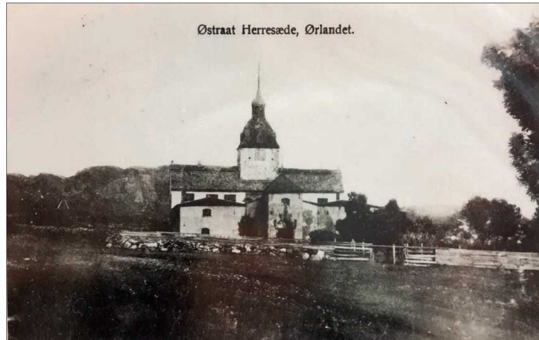
Figur 67. Foto ca 1900. Borgen ser noe forfallen ut, men bildet sier lite om bagens tilstand. Det markante gjerdet forteller oss at veien er lagt om. Brønnbuset vises som svart siluett til høyre for borgens inngang.
