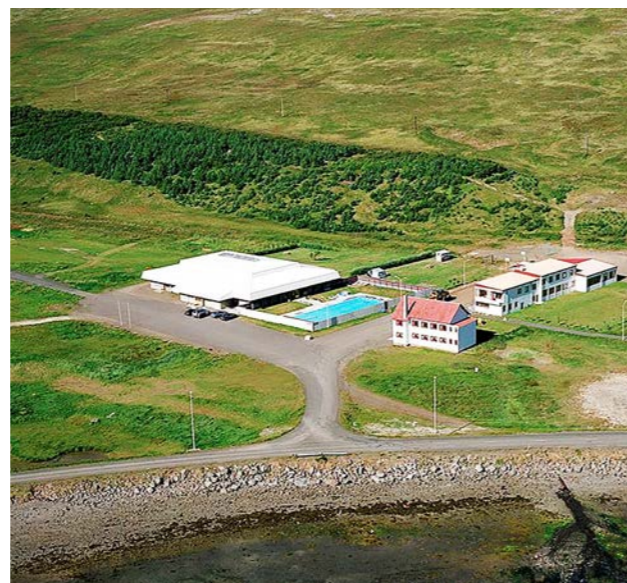
Figur 73: Vannet fra borehull LL-01 er brukt for å varme opp bygdas svømmebasseng, idrettshall og barneskole.
