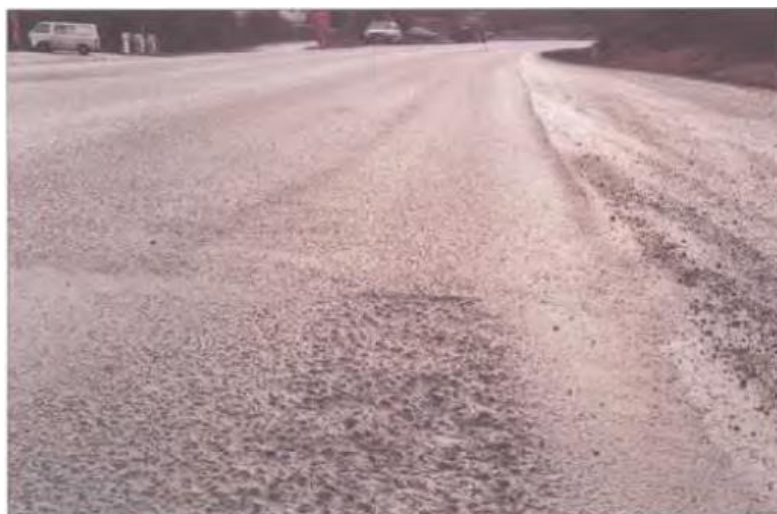
Figur 2.1.6: Steinslipp fra et asfaltdekke. Kopi av figur 2, seksjon 5.4 (Vegdirektoratet 2014b)
