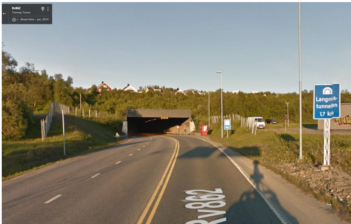
Figur 3.1.2: Bilde av den vestre inngangen til Langnestunnelen (Foto: Google Maps)
