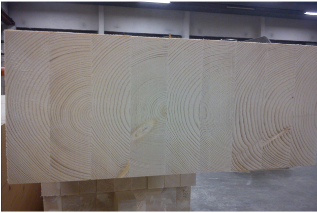
Figur 2: Kantstilt element satt sammen med skruer, Norsk Massivtre
