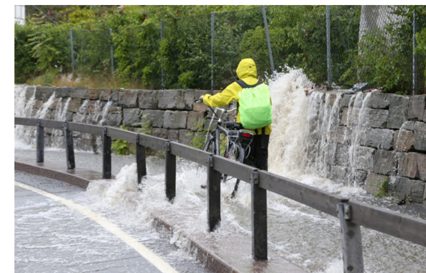
Bilde 5 Vollen i Asker lørdag 6. august 2016. I dette bildet ser vi resultatet av bolig- og vegbygging på vannveier. Bildet viser hvordan overvannet flommer gjennom boligen på den høyre siden og over vegen. Bildet er tatt av journalist Karl Braanaas i Budstikka.
