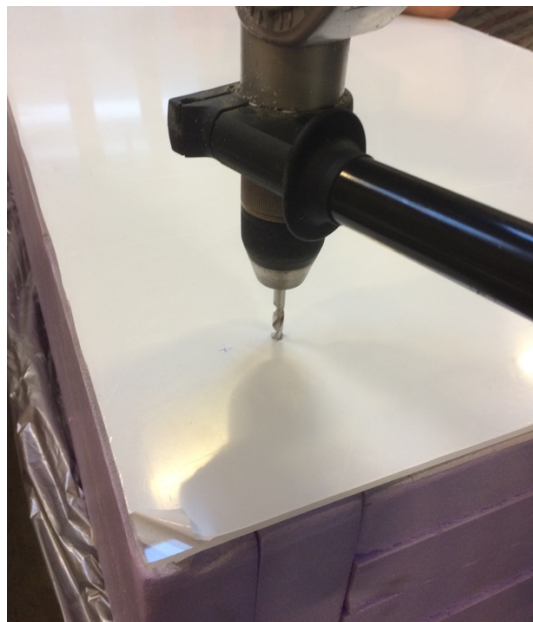
Figur 134: Boring i materialet til testplattformen.
