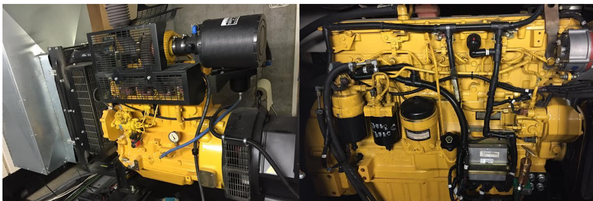
Figur 13: 60 kW dieselaggregat på Hjartøy (privat foto)
