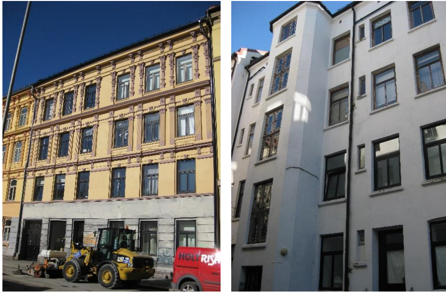
Figur 22: Seilduksgata 26 A, forgårdens fasade mot sør og nord.
