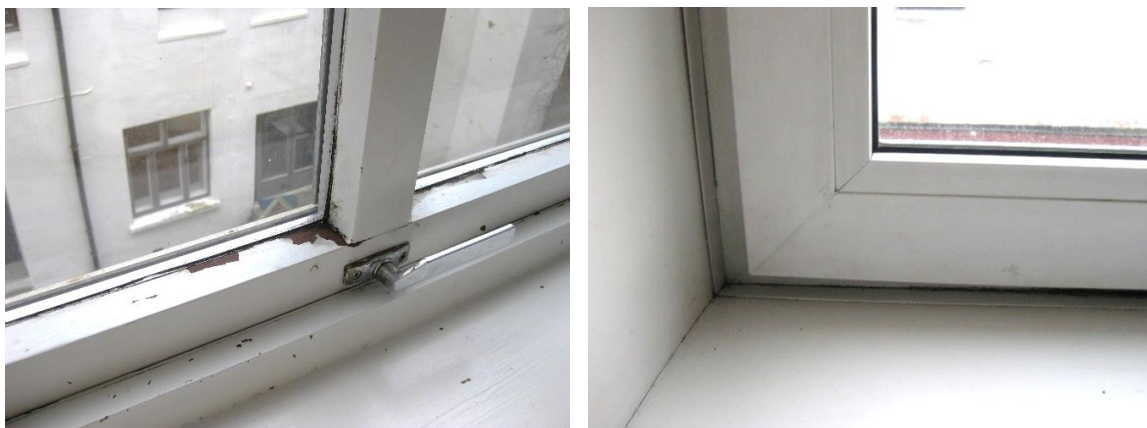
Figur 45: Eldre og nyere vindustyper i leilighet 1.
