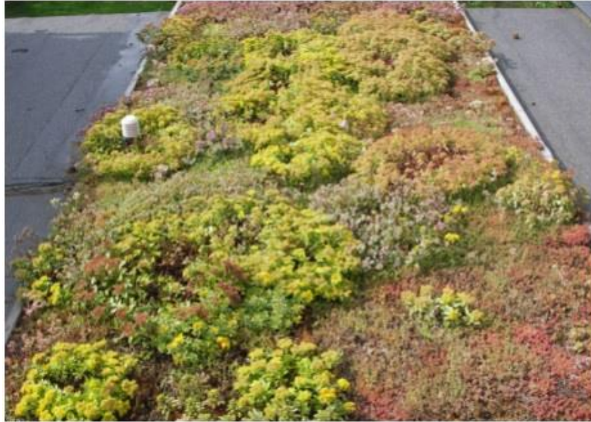
Figur10: Grønne tak med sedum dekke [25].
