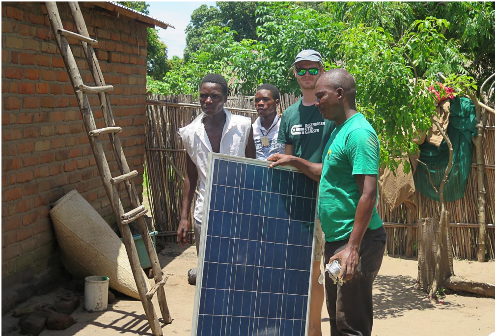
Figur 1 Installasjon av solcellepanel, leie-kjøps-løsning. (eget foto)
