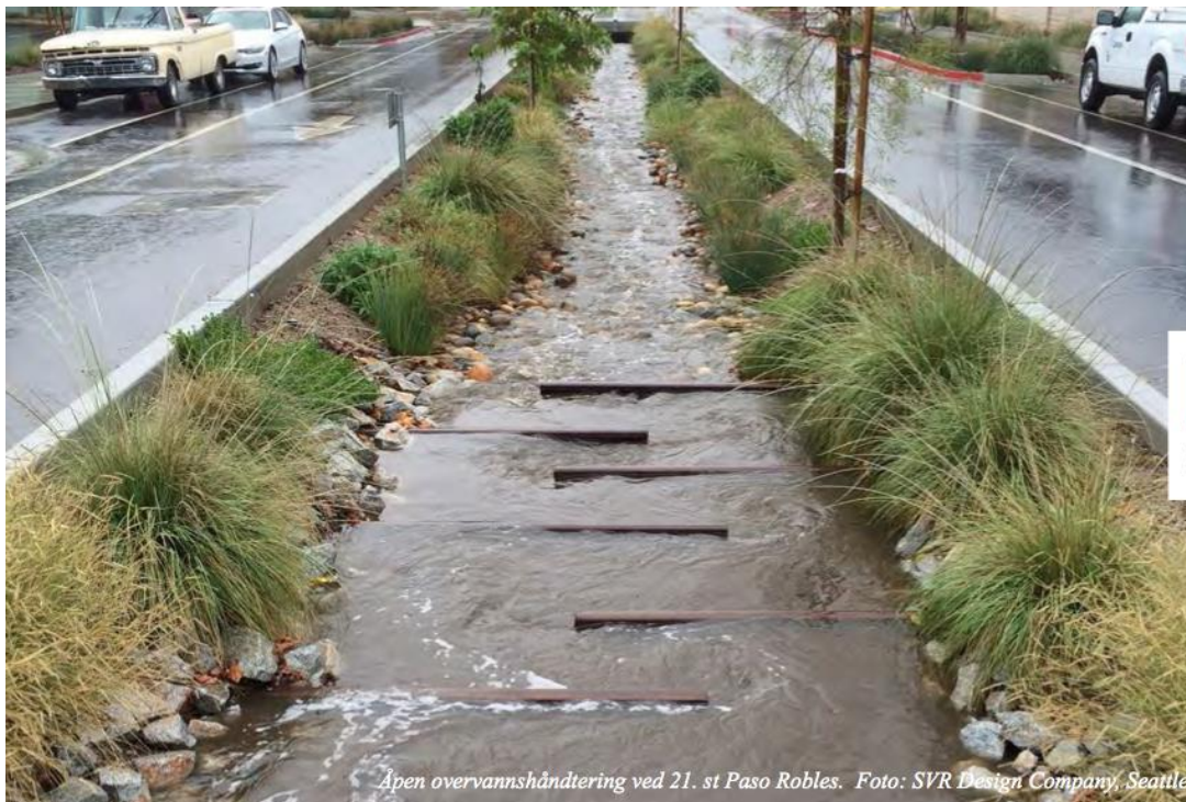
Figur 15: En vannførende grøft kan gi et veldig fint bilde til byen, bidra til lokal infiltrasjon i tillegg til å føre overflødig vann ut av området (Storemyr 2016).
