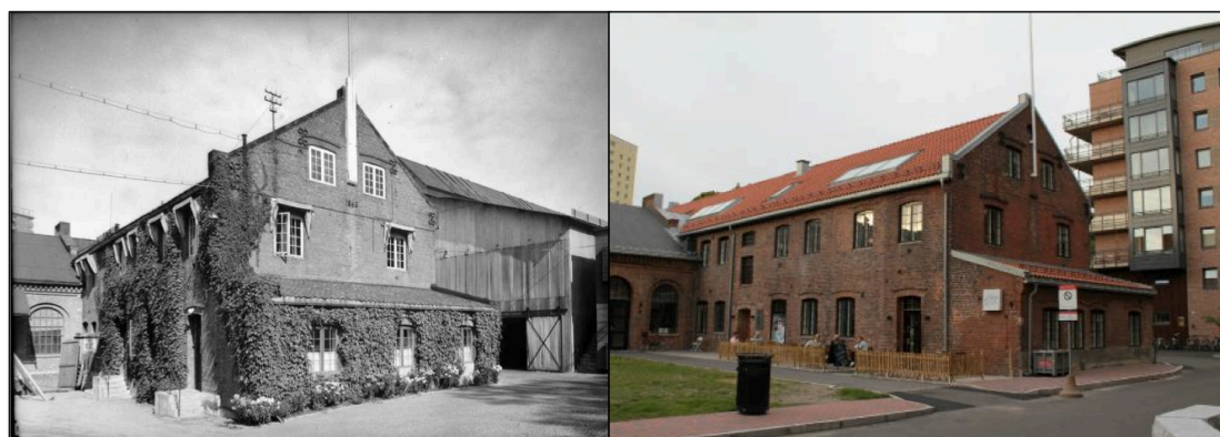
Figur 11 - Før og etter transformasjonen av bygg A4, kilde: Venstre: Brdr. Placht, 2016, høyre: Trip Advisor, 2016
