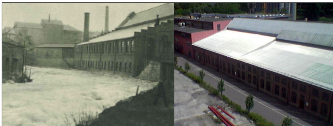
Figur 14 – Bilder av Vulkan før transformasjon, kilde: venstre: LPO Arkitekter, 2016, høyre: Martinsen, 2008
