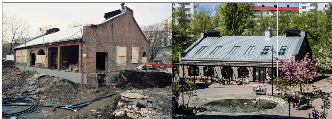
Figur 10 - Før og etter transformasjonen av bygg A2, kilde: André Placht, 2016
