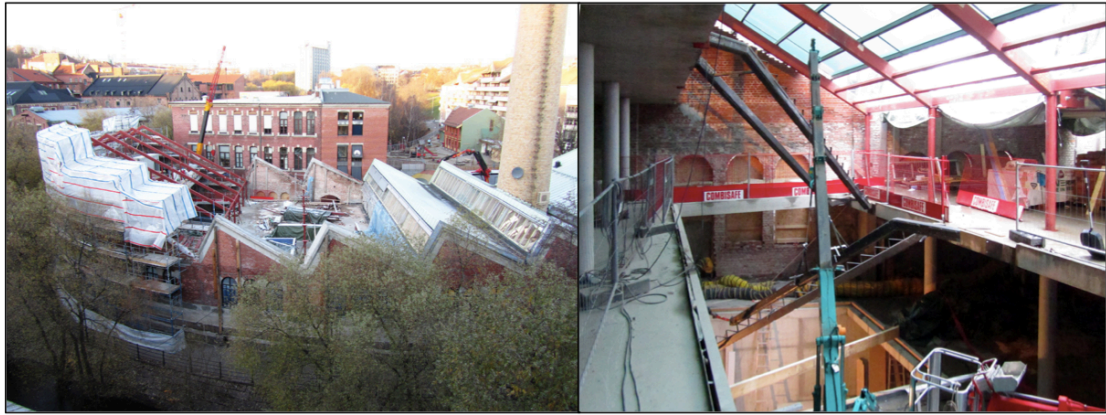
Figur 23 - Under transformasjonen av Nedre gate 5 – 7, kilde: Space Group, 2016
