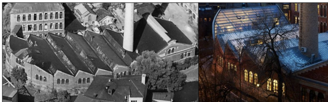
Figur 22 - Nedre gate 5-7 før og etter transformasjon, kilde: venstre: Industrimuseum, 2016, høyre: Engenius, 2016
