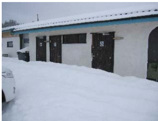
Figur nr.28: HC- toalett er låst og sperret av snø.
