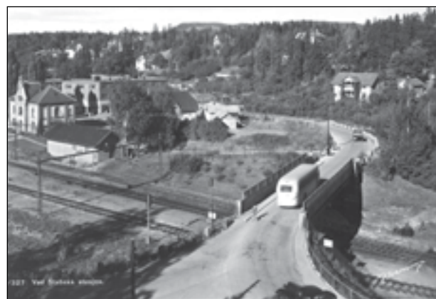
Figur: Foto bilbro over jernbanen ved stasjonen, 1950.
