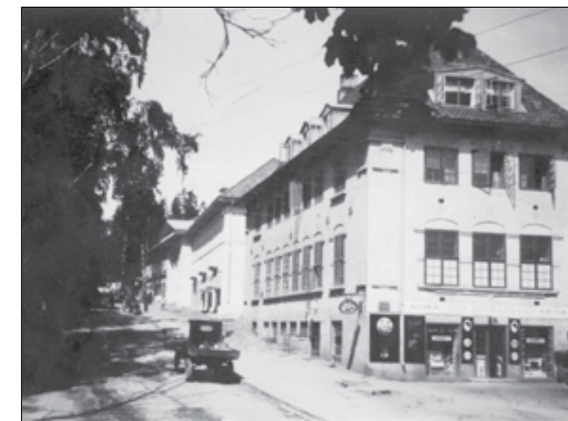
Figur: Foto bakken opp mot kinoen 1920
