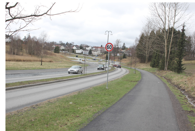
Figur 34: Eksisterende gang- og sykkelveg på strekning 1.1. Forholdsvis sterkt trafikkert strekning.
