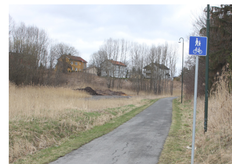
Figur 32: Strekning 1.2 eksisterende gang- og sykkelveg.
