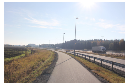
Figur 59: Strekning 1.3, eksisterende gang- og sykkelveg langs Fv. 118 og E6.
