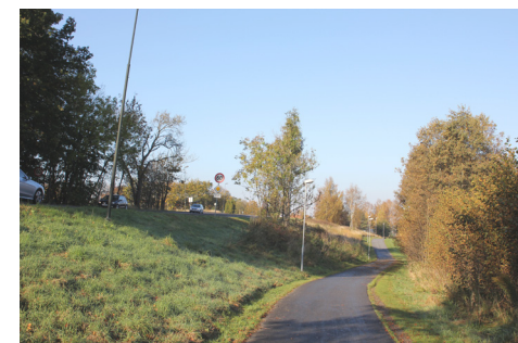
Figur 57: Strekning 1.1, eksisterende gang- og sykkelveg
