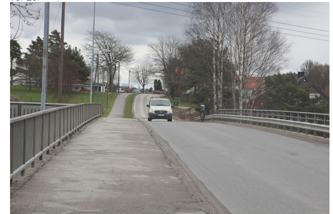
Figur 46: Strekning 1.1, ny sykkelveg medfører behov for utkraging av bro over E6.
