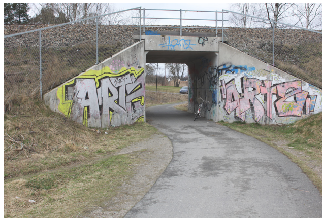
Figur 37: Eksisterende kulvert for kryssing av jernbane.
