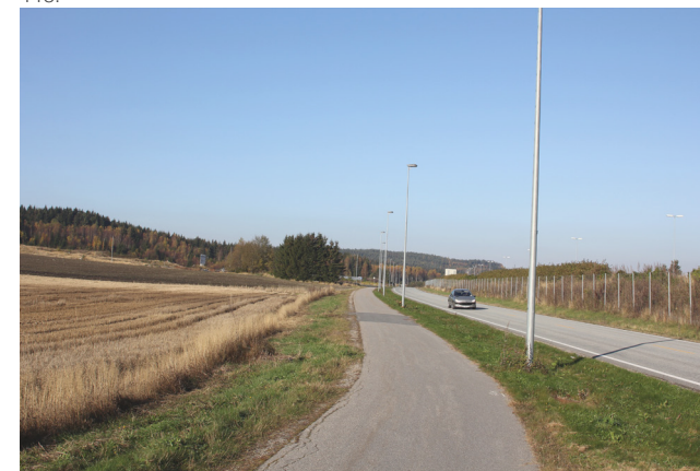
Figur 52: Strekning 1.3, eksisterende gang- og sykkelveg langs fylkesveg 118.
