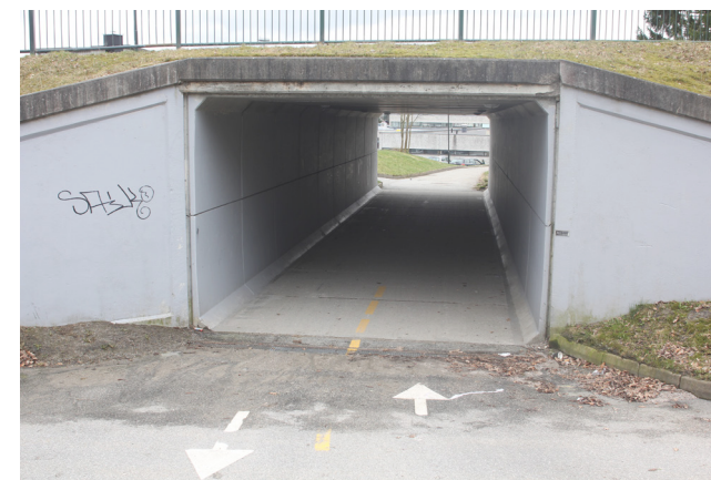
Figur 26: Eksisterende kulvert for kryssing av fylkesveg 118.
