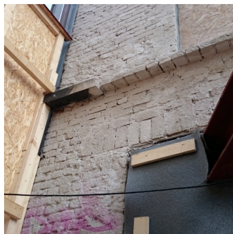
Figur 4-11: Sementbasert puss på ene fasaden (foto: Anita Spjøtvold)
