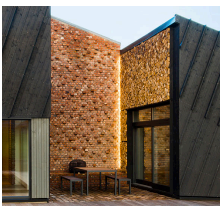
Figur 4-15: Teglkonstruksjonen ble murt opp med murmørtel (kilde: http://www.multikomfort.no/prosjekthus/huset-i-larvik/multikomfort-huset-i-bilder/ )
