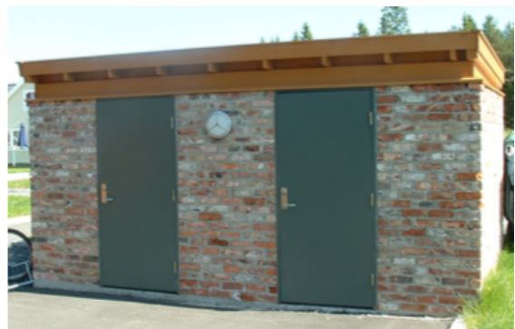
Figur 4-5: Uteboden med gjenbrukstegl (foto: Kenneth Urdshals, Stavne Gård)
