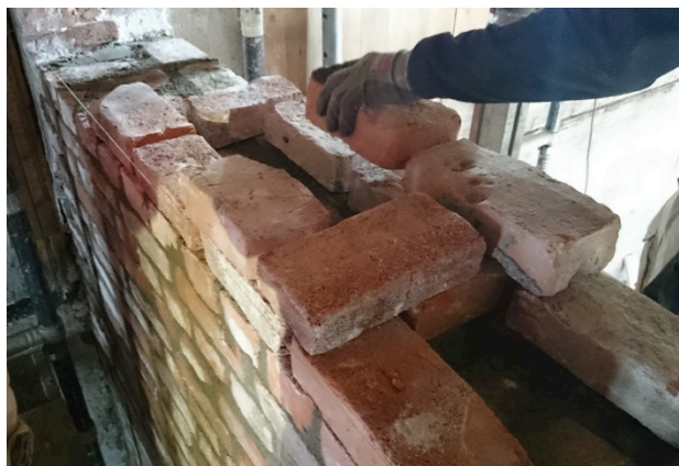
Figur 4-9: Oppmuring av bergens hulmur (foto: Anita Spjøtvold)
