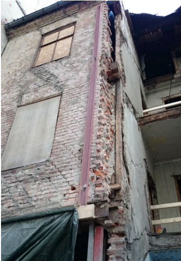
Figur 4-12: Sementbasert puss på ene fasaden (foto: Anita Spjøtvold)
