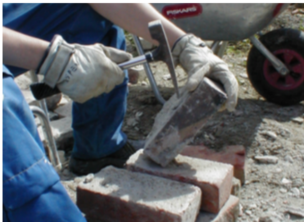
Figur 4-8: Håndrensing ved hjelp av hammer (foto: Njål Pettersen, Miljøenheten)
