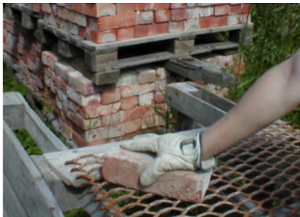
Figur 4-7: Manuell rensing på strekkmnett (foto: Njål Pettersen, Miljøenheten)
