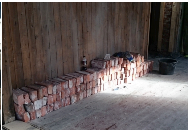
Figur 4-10: Revet teglstein som skal mures opp igjen (foto: Anita Spjøtvold)
