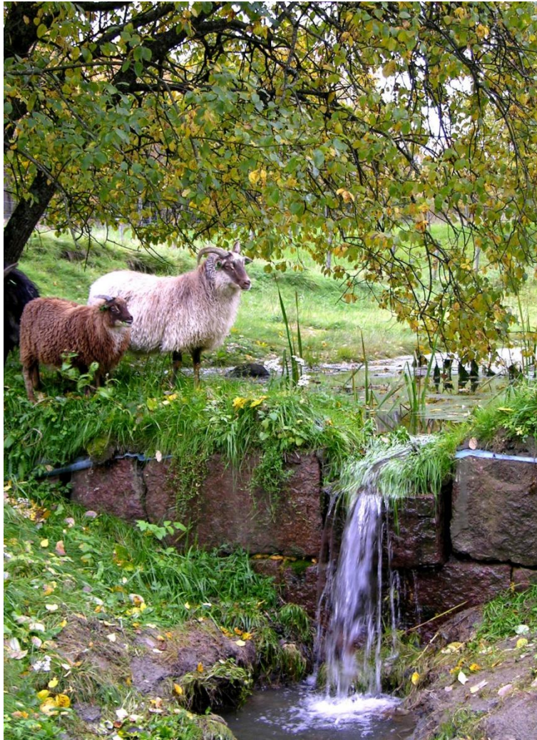
Figur 6: Steinsetting er et av tiltakene for å redusere erosjon. Foto: Ole Christian Torkildsen
