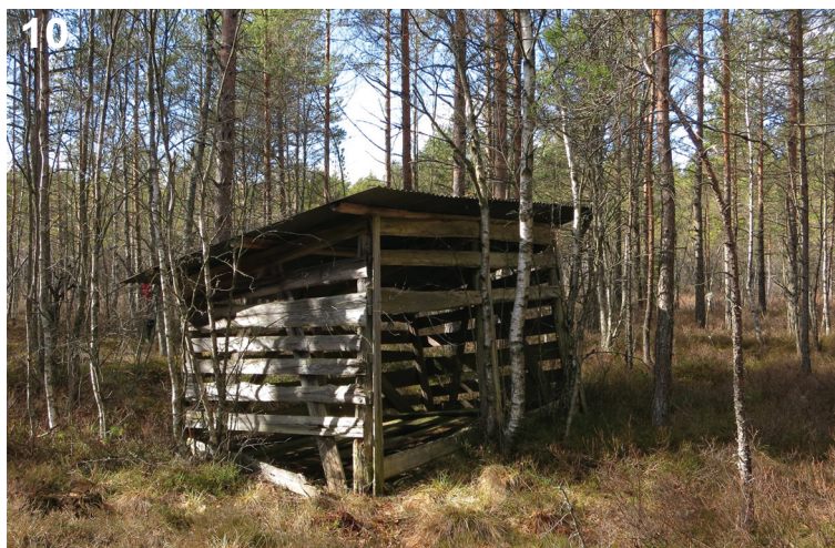
Figur 10. Gjenstående torvhytte i nordøstlige del nær søndre torvgrav (dobble røde streker på figur 2). Remaining peat-hut in the north-eastern part of the bog, close to the southern peat-trench (double red lines on figure 2).
