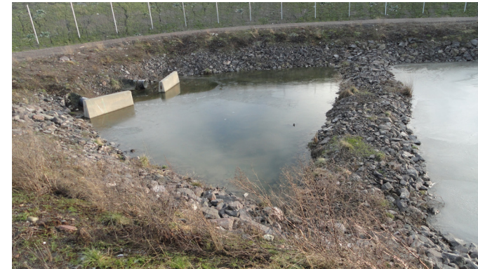
Terskel til høyre i bildet.
