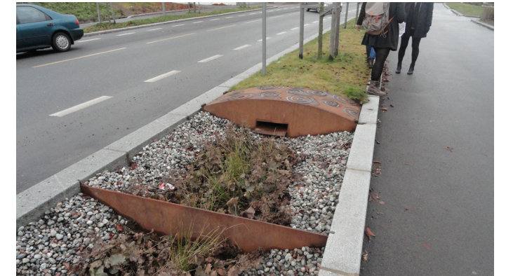
Vegetasjonsgrøft i Oslo.
