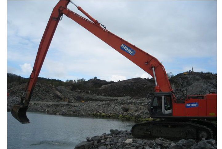
Gravemaskin med lang gravearm som når langt ut i dammen. Hære maskin.no
