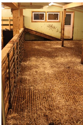
Bilde 3 og 4. Tv: Tett komposittgulv i et fjøs til geit i Nord-Norge. Foto: Marit Gåre. T.h. Et velfungerende komposittgulv med T-profiler. Foto: Grete H.M. Jørgensen.
