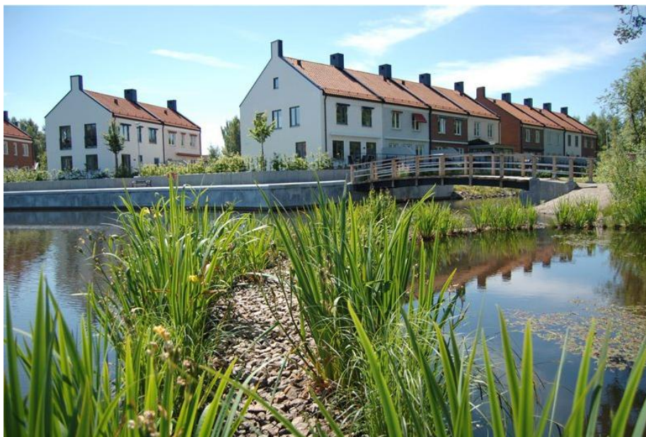
Figur 11: Overvannsdam, Växjö. Foto Veg Tech.
