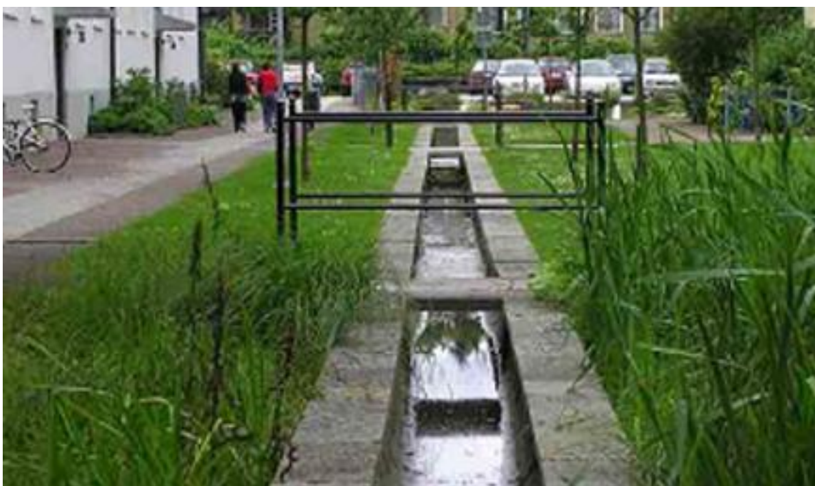
Figur 9: Fordrøyningskanal, Augustenborg, Malmö. Foto: VA-syd.
