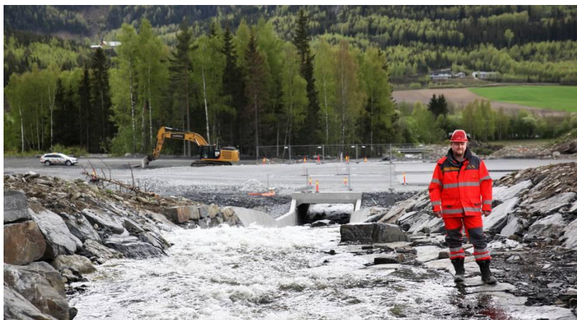
Figur 6: En av de mange flomsikrede småelvene som går under den kommende E6 i Gudbrandsdalen. Foto: Per-Ivar Nikolaisen
