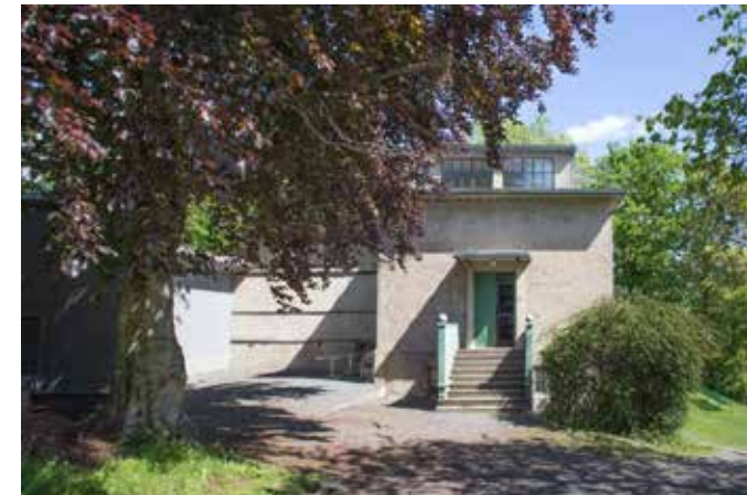
Fig. 134: Vinteratelieret fremstår i dagens situasjon som mer velholdt og autentisk enn på foregående bilde. Sammen med det nyrestaurerte uteatelieret og blodbøken er dette karakteristiske elementer i dagens hage og viktige elementer fra Munchs tid. (Eget foto, 2015)
