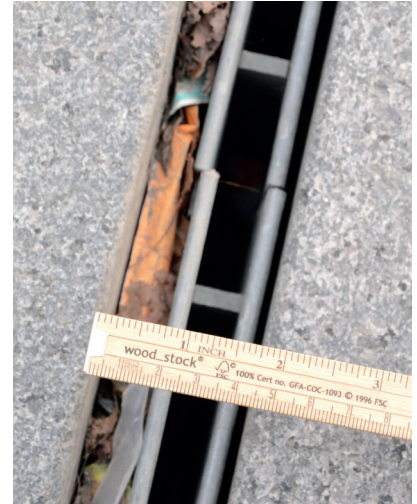
Figur 4.83 Rillene på den grå delen har en bredde på 4,5 cm.
