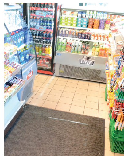
Figur 4.136 Plassen foran skranken er ikke stor nok i følge standarden.
