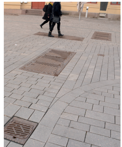
Figur 4.84 Dremsrist og kumlokk i hovedgangaksen.
