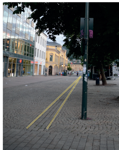
Figur 4.22 En vannrenne (markert på hver side i gult) definerer skillet mellom sonene.
