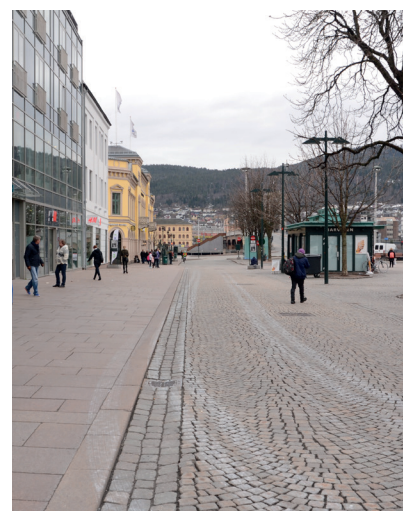
Figur 4.41 Kant mellom heller og gatestein, 3 cm vis.
