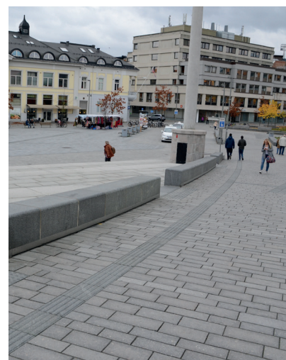
Figur 4.74 Oppgangen til bybrua er brattere enn kravet, og har ingen hvileplan.
