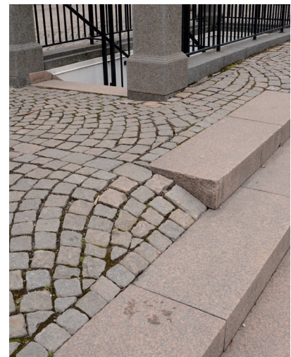
Figur 4.76 Overgangen mellom trappetrinn og omliggende dekke.
