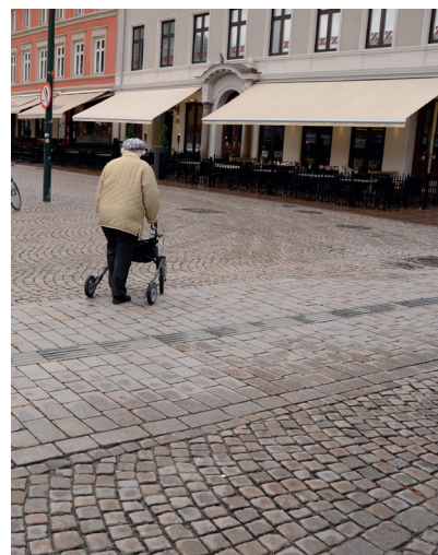
Figur 4.25 Dekket i gangsonen er for det meste gatestein, samt et felt med betongstein.
