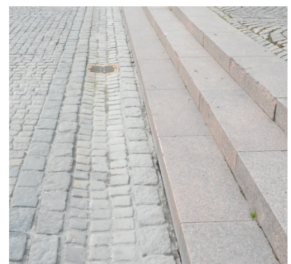
Figur 4.93 I bunnen av trappen er det en drenering i stedet for oppmerksomhetsfelt.
