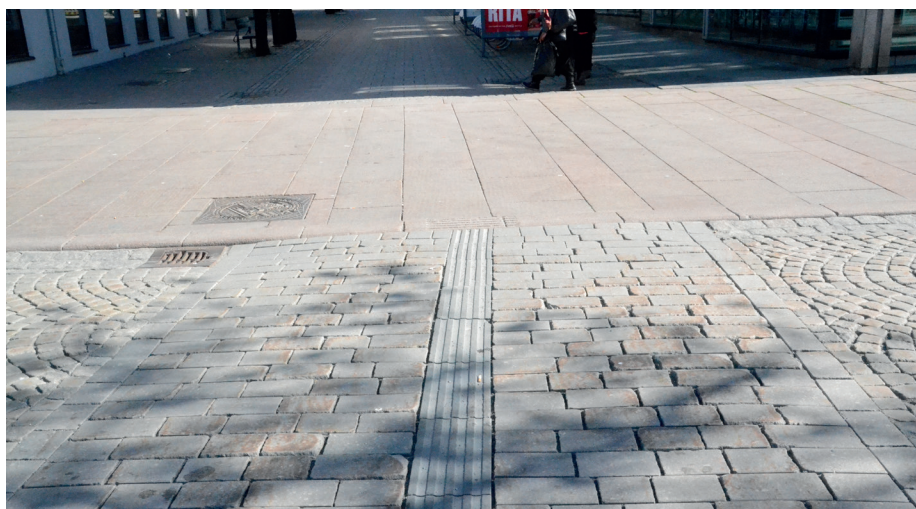
Figur 4.79 Nivåforskjellen mellom heller og gatestein utjevnes ved den tilrettelagte gangveien mellom Festplassen og Handelstorget.
