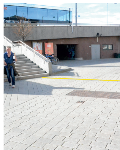
Figur 4.50 De kunstige ledelinjene (fremhevet i gult) slutter ved trappen. Kantsteinen leder videre til undergangen.
