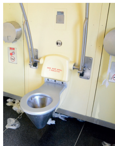
Figur 4.138 Toalettet er tilpasset rullestol. Det er god kontrast mellom vegg og gulv.
