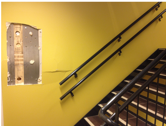
Figur 1.1-5: Gips fjernet i trappesjakt mellom 2. og 3. etasje
