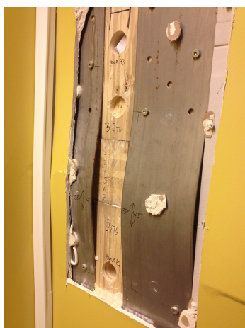
Figur 4.2-1: Utbuling av stålbeslag 19.02.14
