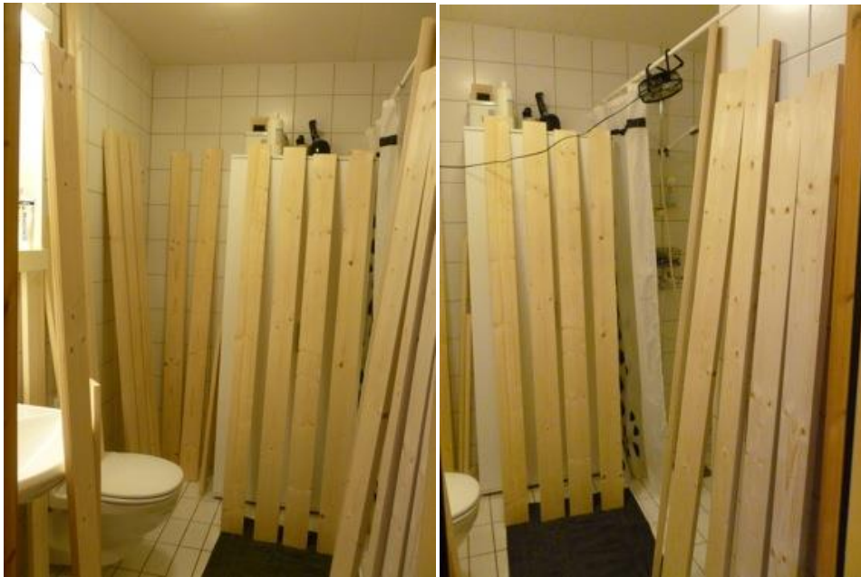
FIGUR 17 - BILDENE VISER TREPLANKER FORDELT UTOVER BADEROMMET. BILDET TIL HØYRE VISER HVORDAN VIFTEN BLE PLASSERT
