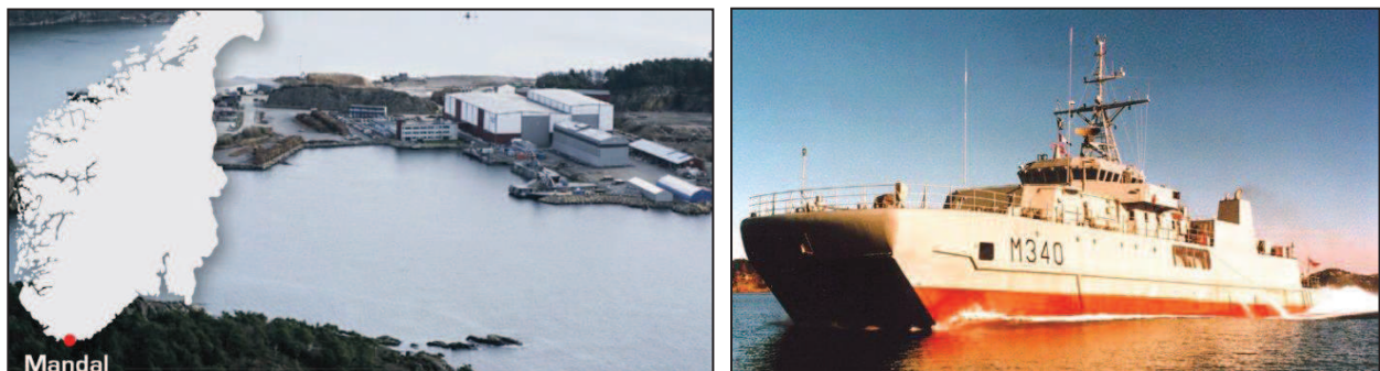
Figur 6: Oversikt over verftet og kontor lokalene, til Umoe Mandal på Gismerøya utenfor Mandal.[S.2] (t.v.)Oksøy klassen som Umoe Mandal bygget for det Norske Forsvaret på 90-tallet.(t.h.),[S.2].
