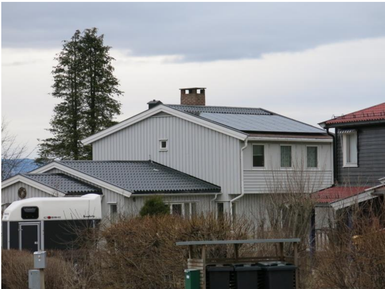
Figur 3-8: Det sydvendte taket til Kjell Eikland har 3,84 kWp installert solcelleeffekt. Foto: Knut M. Solbakken.
