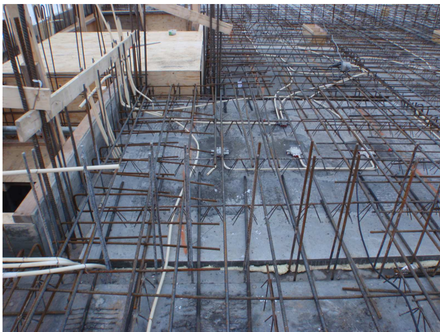
Figur 25 – Føringer lagt ut i plattendekke før påstøp (Dr Munch Park)
