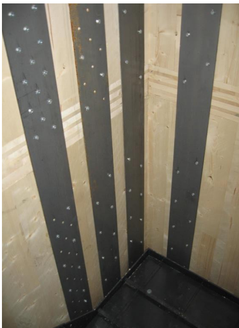
Figur 1.5: Kontinuerlige stålplater i heis- og trappesjakten.
