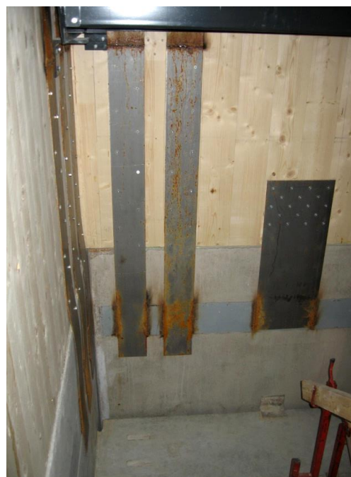
Figur 1.6: Stålplater forankret til fundament i heis- og trappesjakten.
