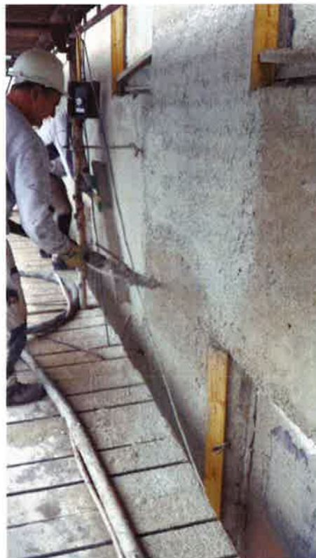
Figur 11: Pussen sprøytes på, og rettes av.
