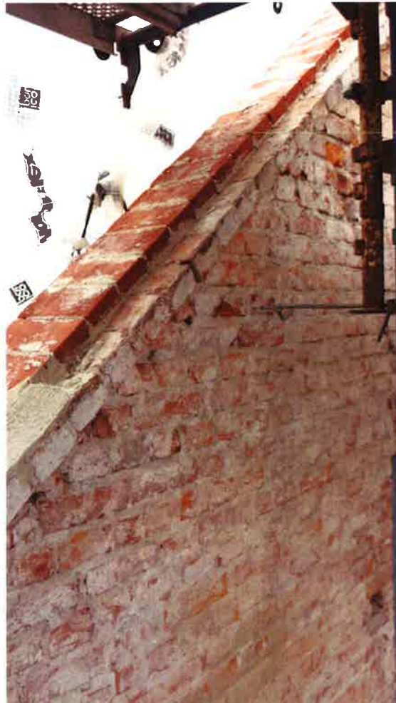
Figur 10: Veggen er klar for pussing
