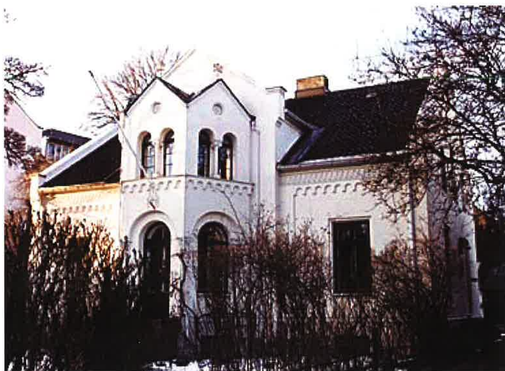
Figur 7: Bygget sett forfra [12]
