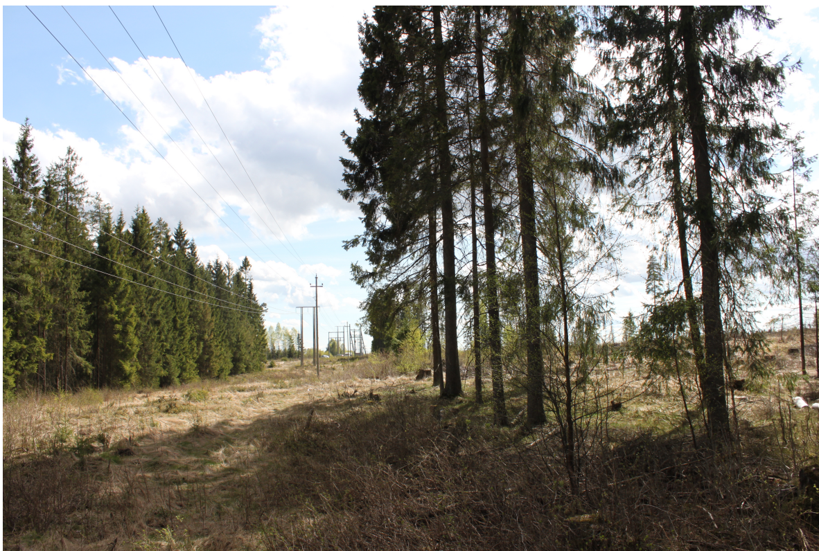
Foto 3: Kantskog observert i område 7. Store trær som har stor sannsynlighet for å falle over linja ved kraftig vind
