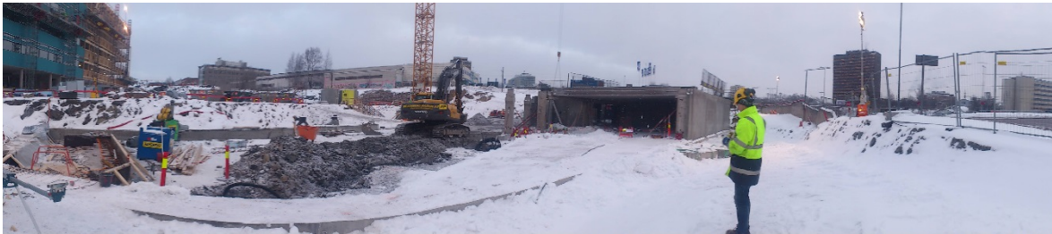
Figur 31 Montasjeplass i Hasle, Oslo.
