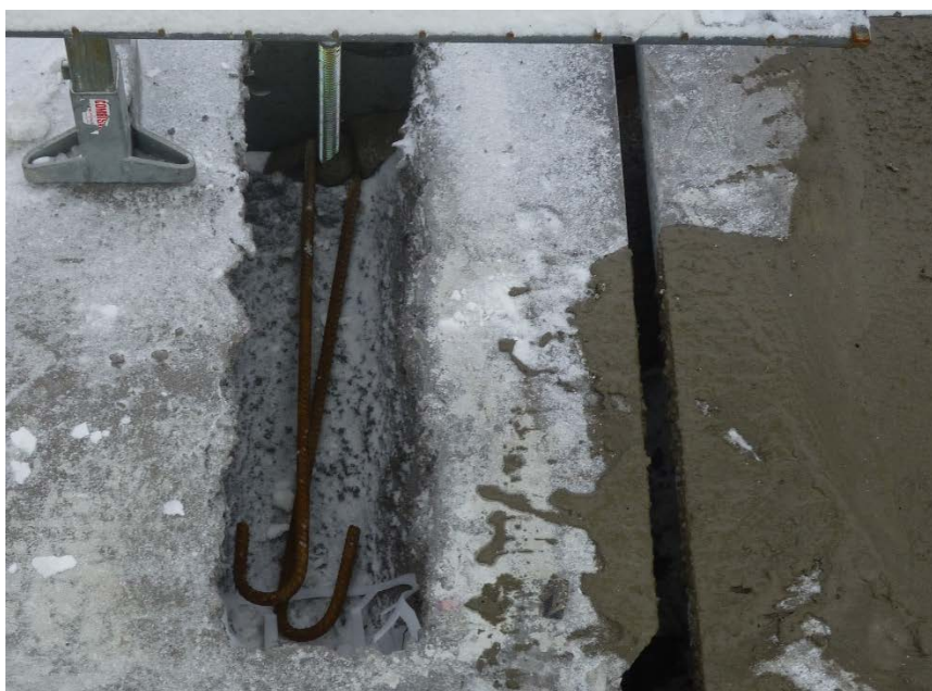
Figur 14 Kanal og skjærfuge i hulldekke.
