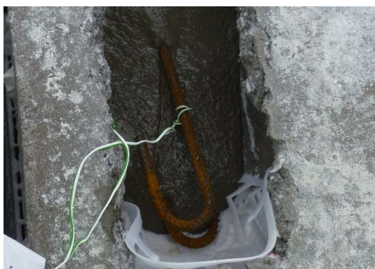
Figur 35 Plassering av termoelementene på bøylene i HD kanal.
