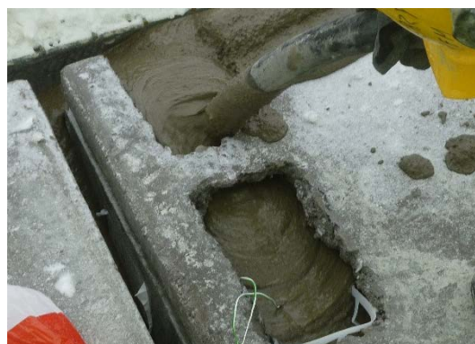
Figur 34 Pumping av fugebetong inn i HD kanal.
