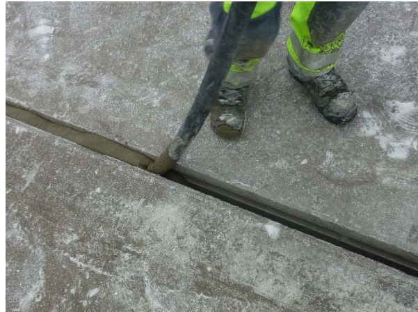
Figur 1 Fugebetong pumpes inn mellom nedkjølte hulldekker.
