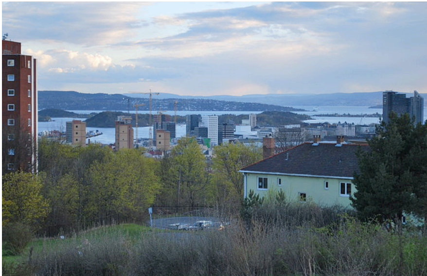
Bildet tatt fra Hasleparken. Helt til høyre kan en se Postgirobygget og SAS hotellet. I midten ser en toppen av Barcode rekka og gravemaskinene. (Illustrasjon 49)
