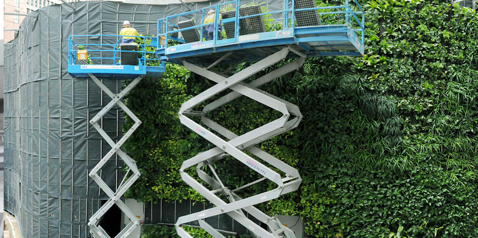
Bilde: 1.34 Installasjon av et levende veggssystem
