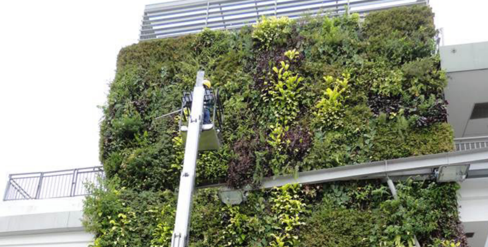
Bilde: 1.33 Vedlikeholdsarbeid på et levende veggssystem
