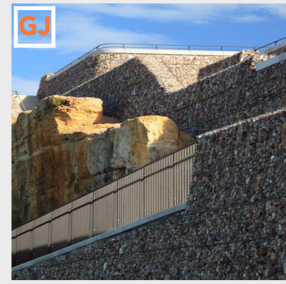
Gabioner Betong og andre materialer fra revet bygg knust og gjenvunnet som fyllmasse i gabioner. Ballast Point Park, Sydney, Australia 2009 Mcgregor Coxall http://mcgregorcoxall.com/projects/30#/projects/30 (Hawken 2009)
