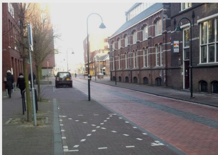
Bilde 30 c. Sykkelgate i Nederland med bufferfelt i midten og parkering på en side (Groot 2007).
