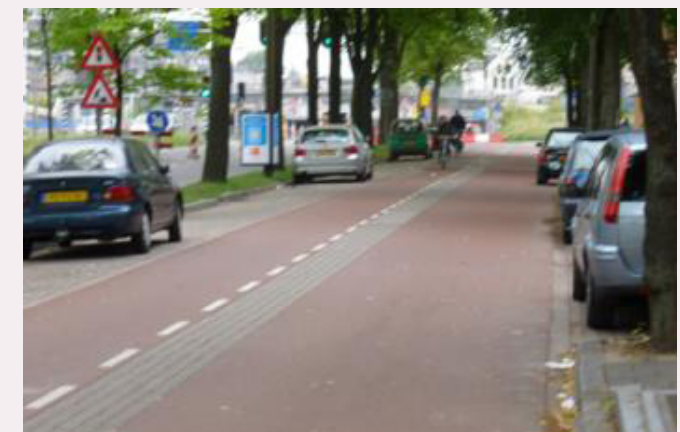
Bilde 16. sykkelgate med syklister på hver side, i gate som er enveiskjørt for biler (Groot 2007).
