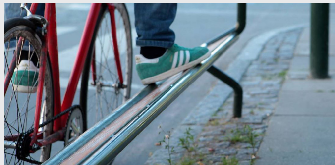
Bilde 35. av fotstøtte, som gjør det sikrere og mer komfortabelt for syklisterne å vente på grønt lys (Ramsdal 2012).
