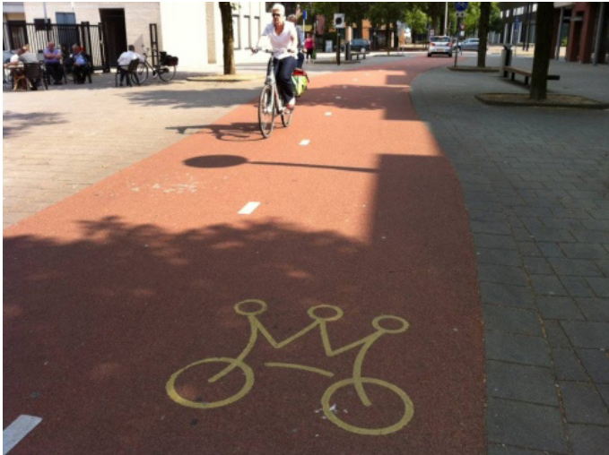
Bilde 34: Eksempel på oppmerking av sykkelgate og sykkelsymbol i sykkelgate i Oss, Nederland (dagblad 2012).
