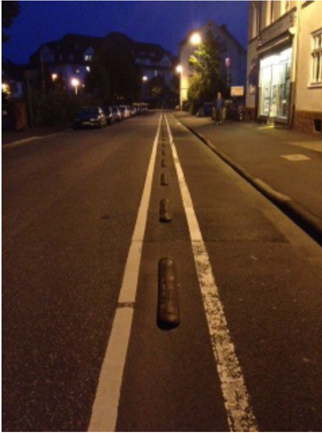
Sykkelfelt i Tyskland Marburg med dumper i gummi for å hindre bilister i å kjøre i sykkelfeltet. Det kan være vanskelig å benytte disse i Norge på grunn av snøbrøyting. Foto: Kristine Sand
