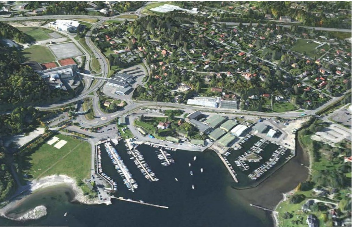
Figur 2. Bildet viser Holmen friområde til venstre, Holmenskjæret Båtforening og tilhørende båtplasser (de to bryggene lengst til høyre), og Holmen Slipps eiendom som strekker seg fra Holmenskjæret Båtforening og bort til Neselva. Holmen gård ligger midt i bildet inne på Holmen Slipps område.
