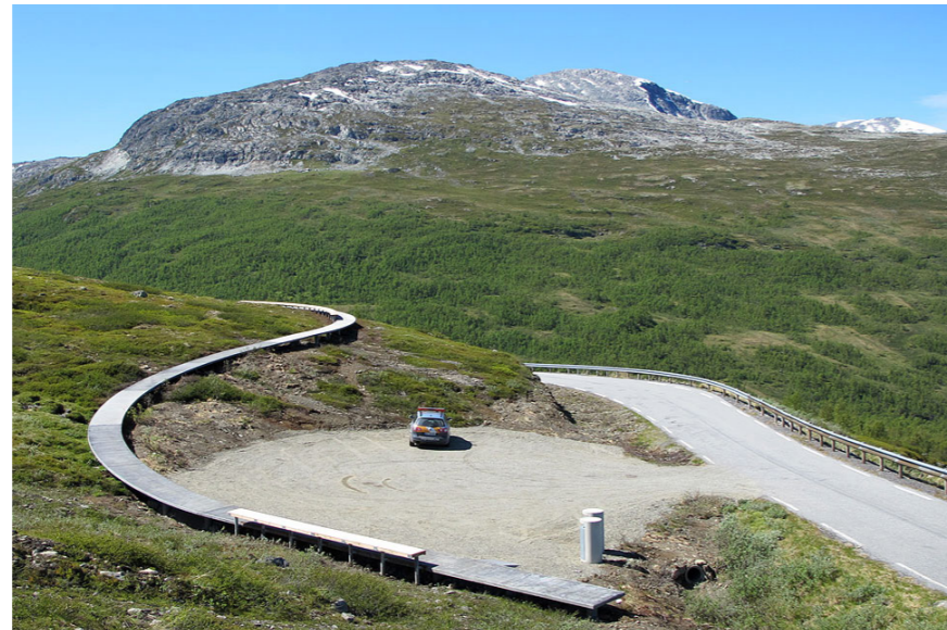
Bilde 3.25: Skånsom tilrettelegging ved Vedahaugane med gangbane i betong
