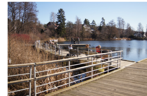
Bilde 3.14: Brygga innerst i Lillebukta blir benyttet som oppholdsareal av mange.
