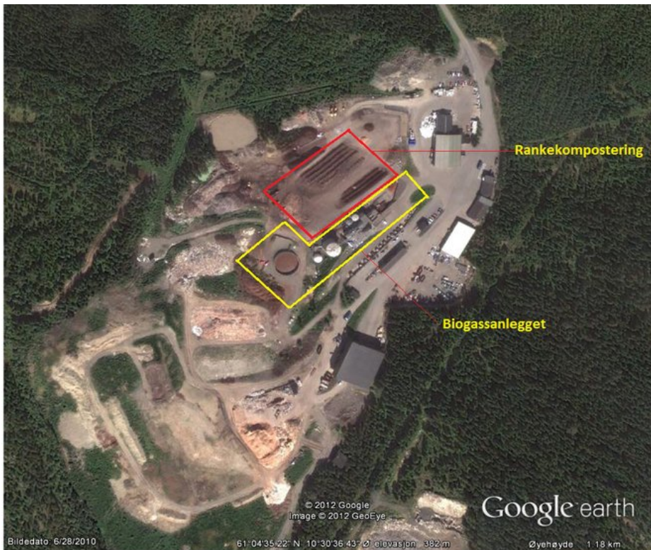
Figur 11: Mjøsanlegget sett ovenfra. Komposteringsareal merka med raud ramme, sjølve biogassanlegget med gul ramme. Kartretning er nord. (google earth)
