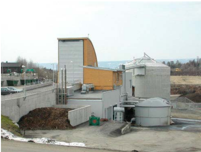
Figur 12: Mjøsanlegget. (frå MA rapport 2012) sett frå nord.
