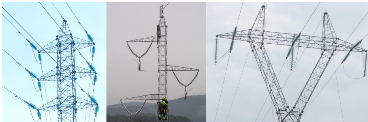
FIGUR 34: TRE FORSKJELLIGE TRAVERSER. (BILDER: OMEGA ELKRAFT)
