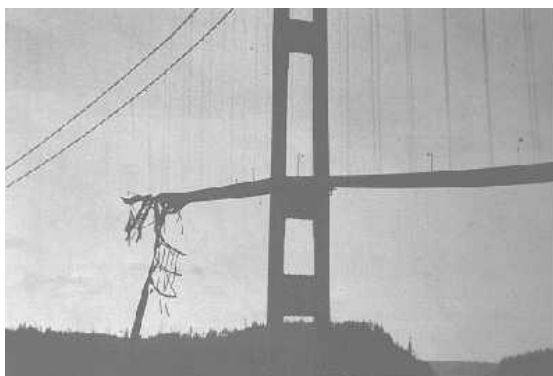
FIGUR 86: TACOMA NARROW BRIDGE I WASHINGTON KOLLAPSET I 1940, TROLIG PÅ GRUNN AV RESONANS SKAPT AV VIND. (72)
