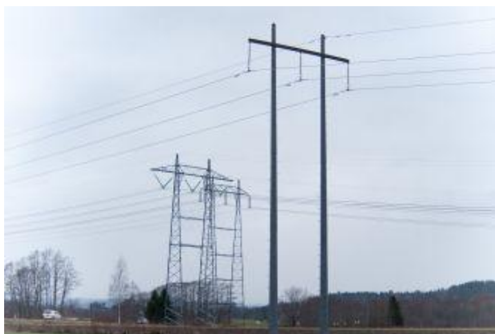
FIGUR 16: KOMPOSITTMAST TIL HØYRE OG VINKELSTÅLMAST TIL VENSTRE(21).
