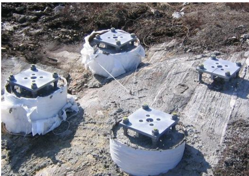
FIGUR 102: FUNDAMENTER PÅ FJELL (BILDE: OMEGA ELKRAFT)
