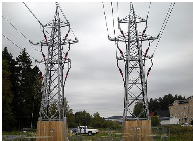
FIGUR 15: VINKELSTÅLMASTER(20).
