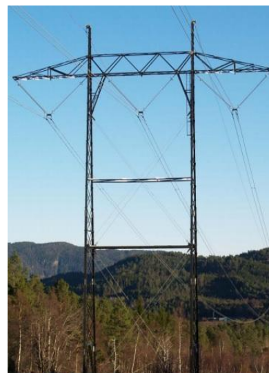
FIGUR 14: RAMME, H-MAST MED VINKELSTÅL (19).
