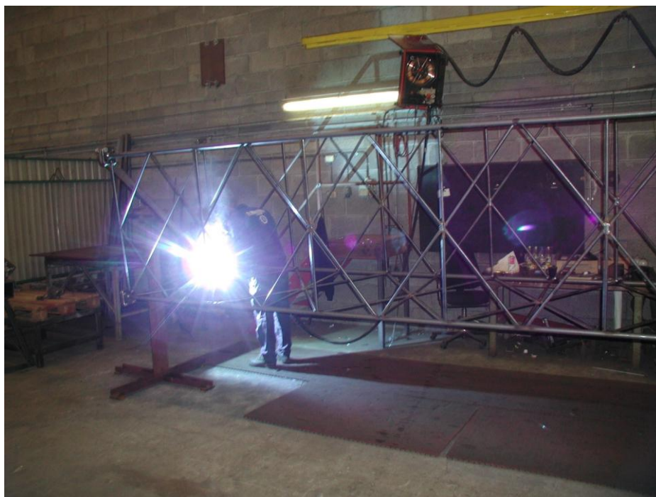
FIGUR 91: SVEISING AV SEKSJON (BILDE: OMEGA ELKRAFT)
