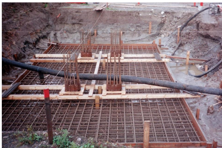
FIGUR 103: JORDFUNDAMENT (BILDE: OMEGA ELKRAFT)
