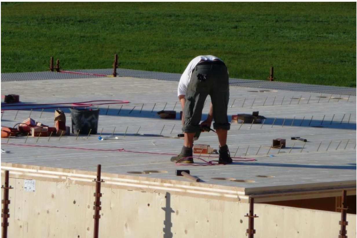
Figur 2: Montering av skrueforbindelser i massivtre, studenthybler i Palisaden i Ås.
