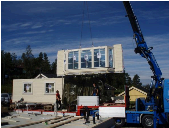
FIGUR 15. PREFABRIKERT VEGGELEMENT LØFTES PÅ Plass (Våge et al. 2009 s. 32).
