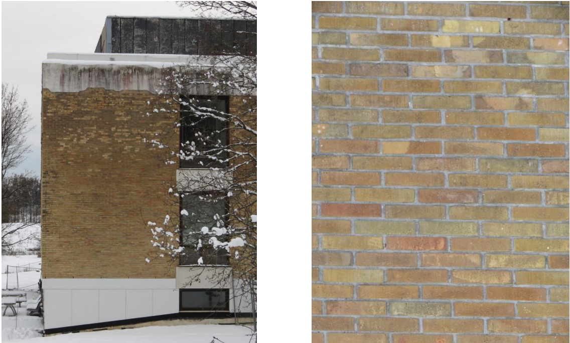
Figur 2.6: Sørlege fasaden av Kjemisk Analyse bygget på Campus Ås der bilete til høgre vert nytta for identifisering av murstein.
